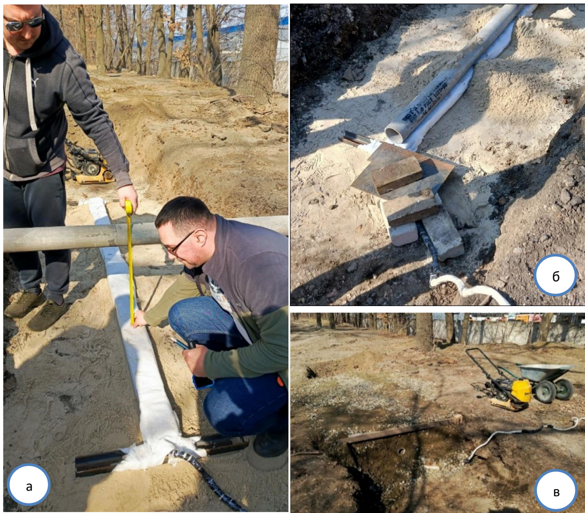
Рисунок 12 – Захист вантажної платформи від потрапляння сторонніх предметів в її конструкцію (а); захист кабелю передачі даних (б); опалубка для візуального контролю стану дренажної труби (в) Figure 12 – Protection of the cargo platform from foreign objects entering its structure (a); protection of the data transmission cable (b); formwork for visual inspection of the condition of the drainage pipe (c)
